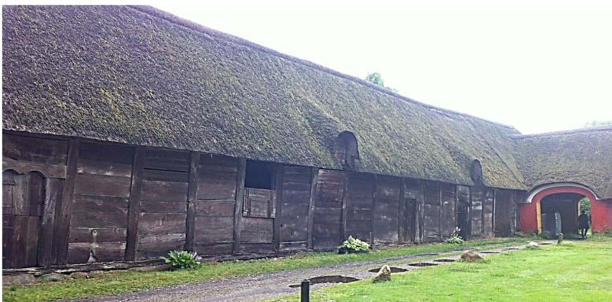
Tyrstrup bullade ved Christiansfeld. Opført i 1668. Vi kan se at der stort set ikke er skiftet nu i de bærende konstruktioner eller ydervæggene siden 1668.
